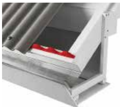
Joonis 47. Katuseräästa viimistlus kaetud vihmaveerenniga.
