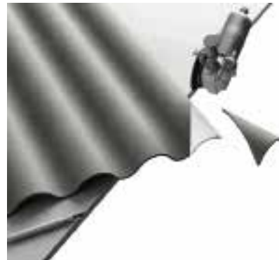
Joonis 14. Üks plaatide nurkade lõikamise näide. Lõige on tehtud betoonilõikekettaga varustatud nurklühvijaga.
