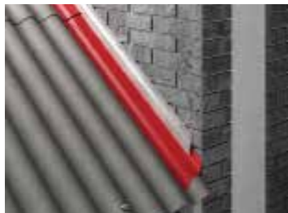
Joonis 45. Katuseviilu ja hoone seina ühenduskoha ehitamine.
